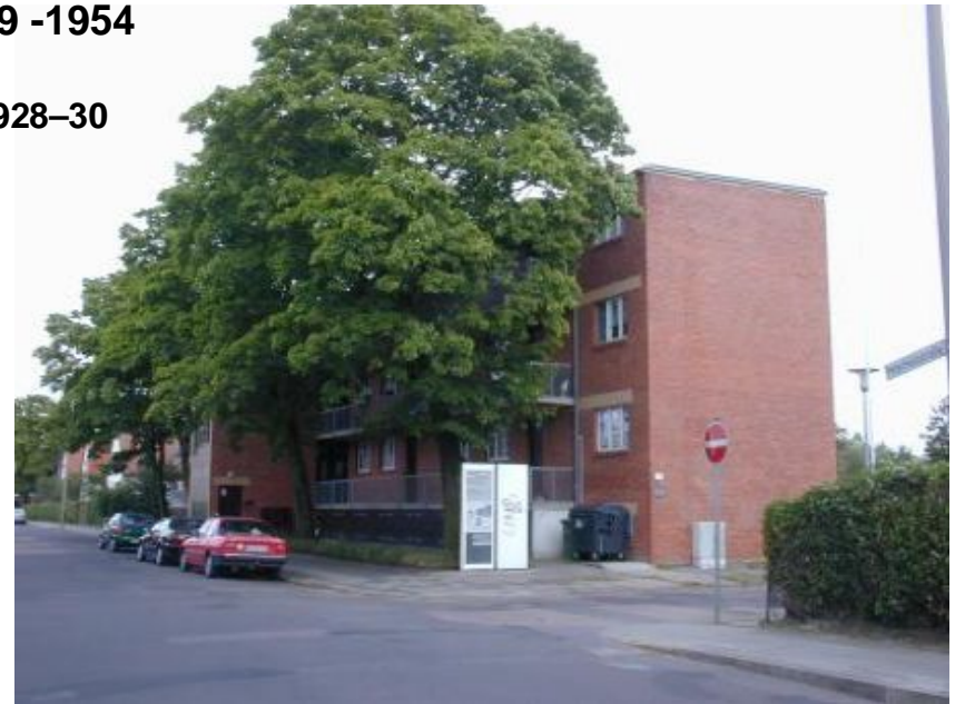
residential complex Dessau - Törten 1996
